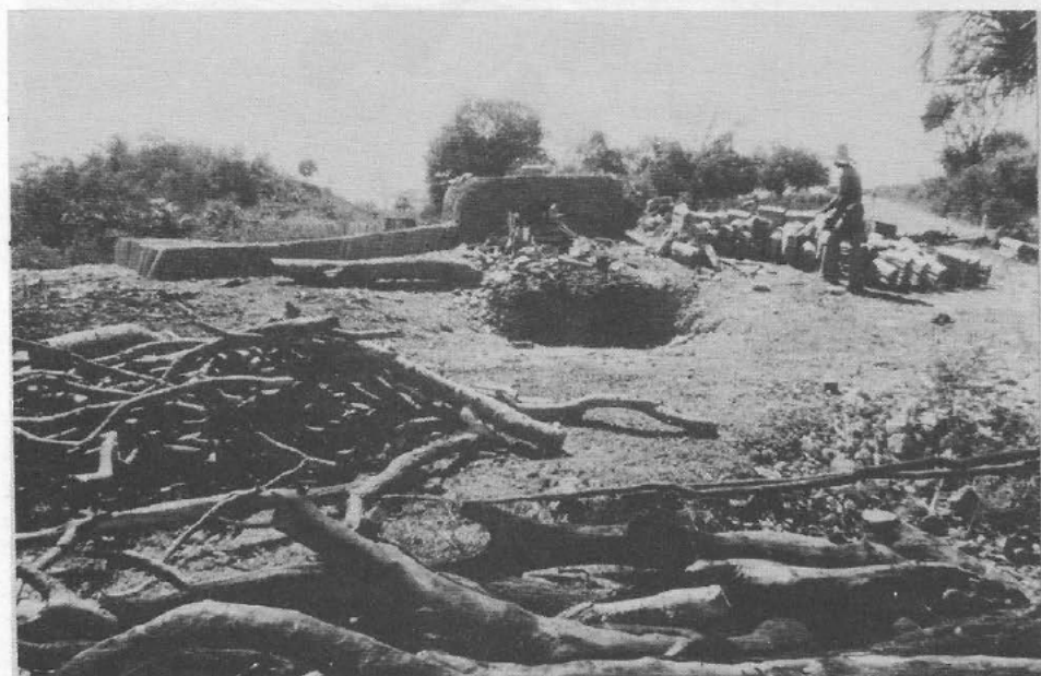
14. Vista do forno que vem sendo utilizado desde 1948, construído sobre um barranco. À esquerda, as telhas prontas para serem queimadas e à direita, as telhas já queimadas.
