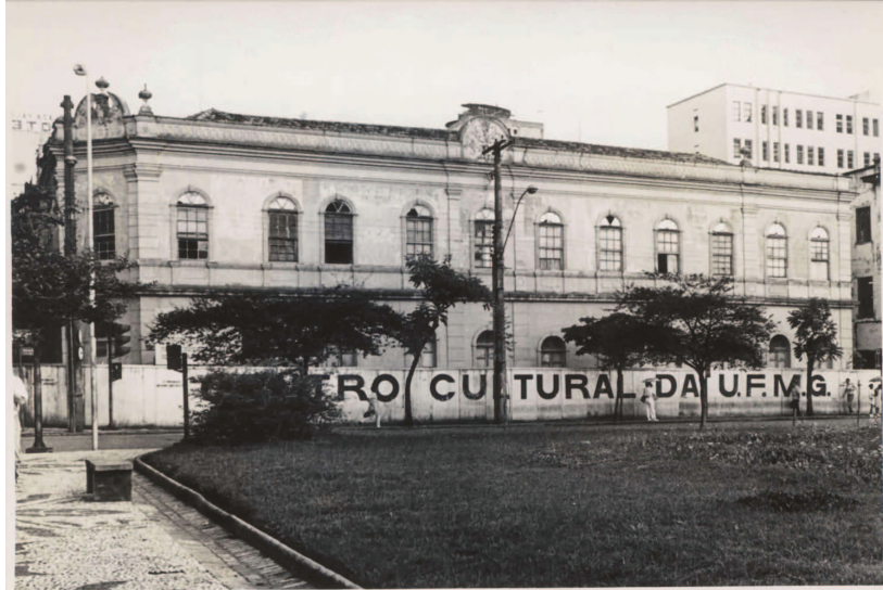
Figura 2. Prédio do Centro Cultural da UFMG durante sua reforma em 1989.
