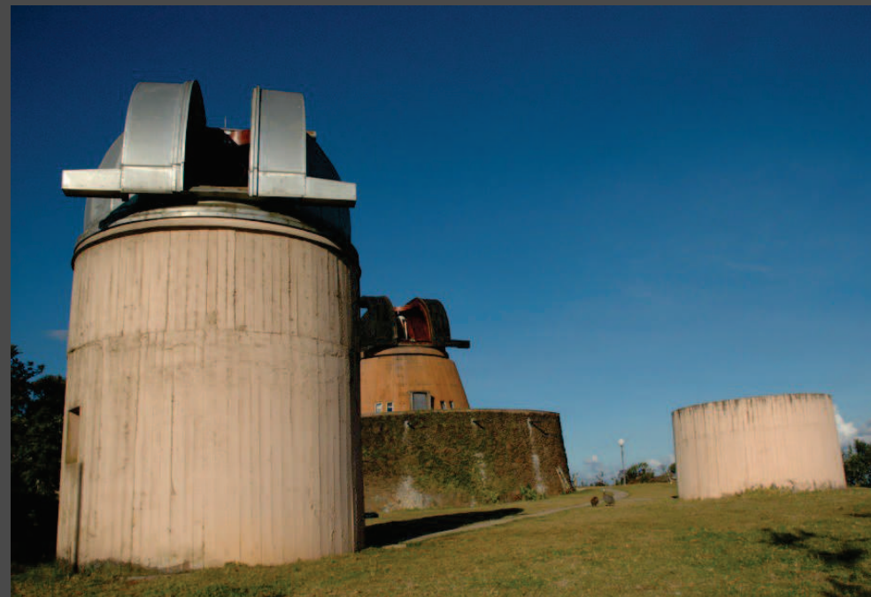
Observatório Astronômico UFMG
