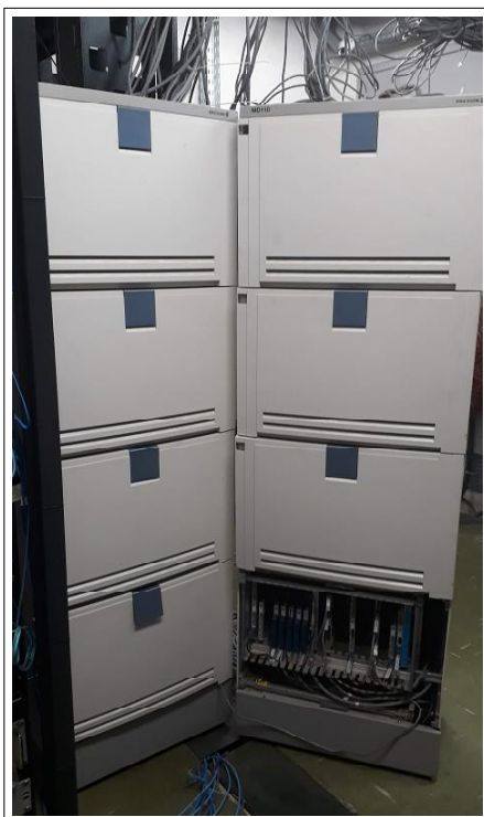
O rack com 4 magazines da antiga Central Telefônica da Reitoria
