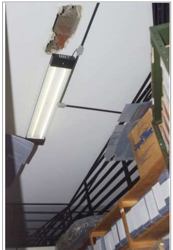
O teto da sala do Arquivo inativo
