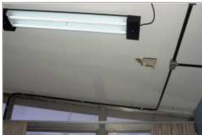
Buraco aberto na Sala 8014 para saída da água
