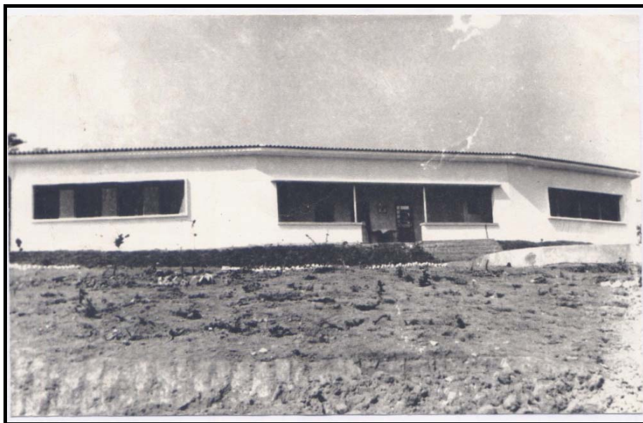
Figura 06: Construção da sede da “Estação Experimental” em 1977 que até hoje abriga a sede da Estação Ecológica. Fonte: Arquivo DPFO.
