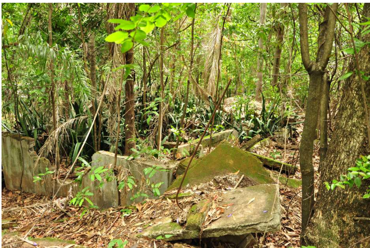
Figura 56: Escombros da antiga Capela na EEco-UFMG.
