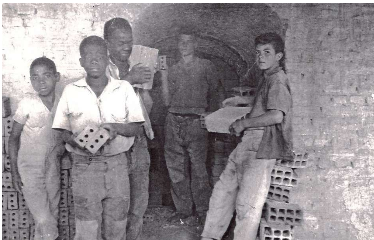
Figura 46: Meninos com tijolos em uma das entradas da câmara de queima do forno. Fonte: Acervo da EEco-UFMG, sem data.
