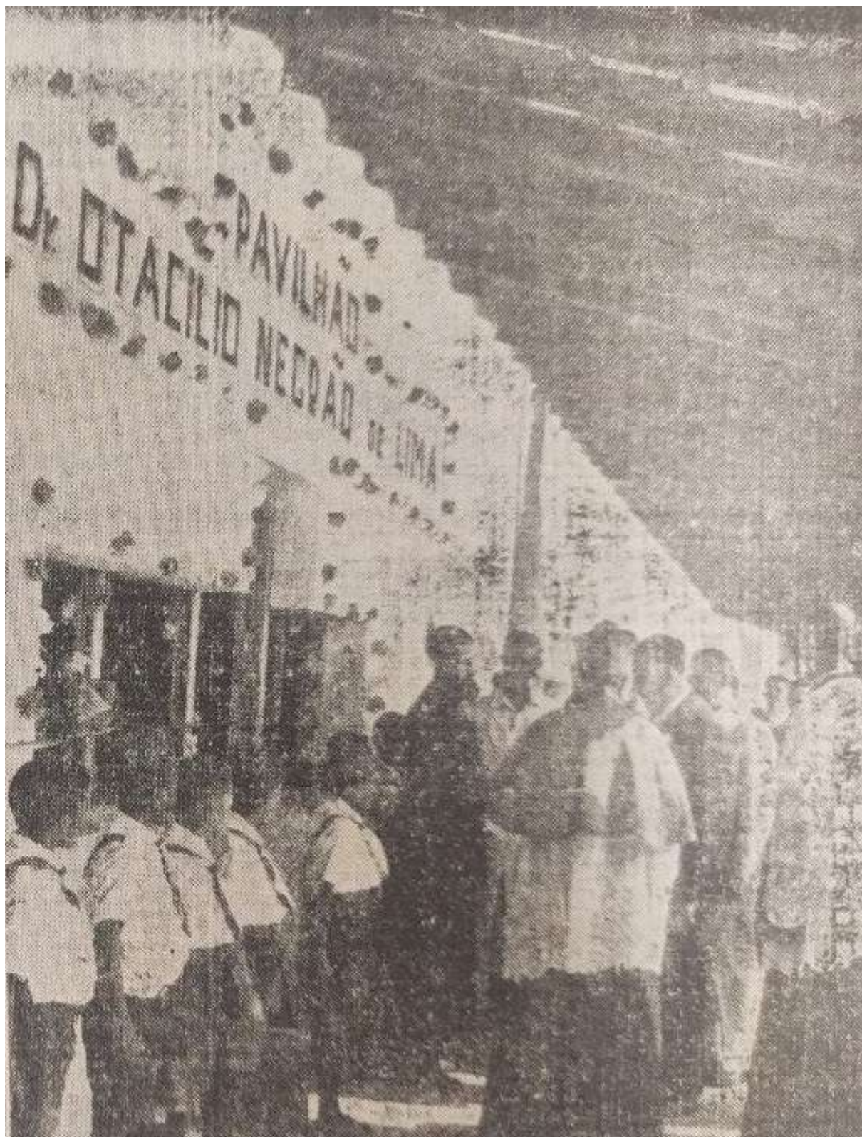
Figura 5: Inauguração do Pavilhão Dr. Otacílio Negrão de Lima. Fonte: Diário de Minas, 1949; Hemeroteca Histórica.
