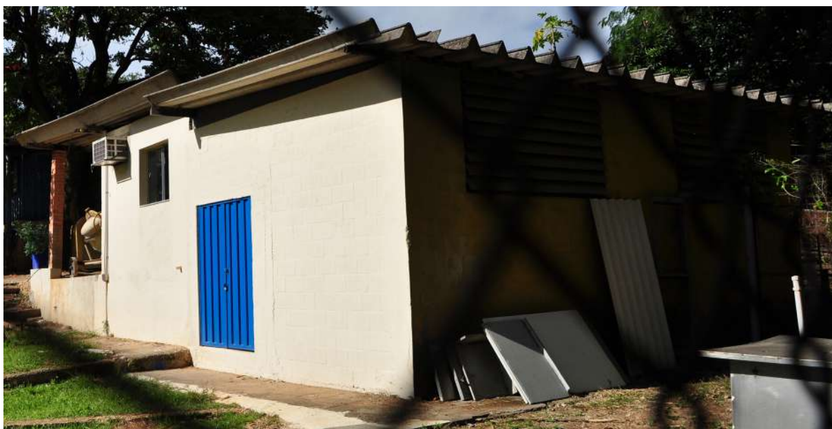
Figura 64: Construção no CDTN onde foi o Campinho de Futebol 3. Fonte: Acervo da autora, 2025.
