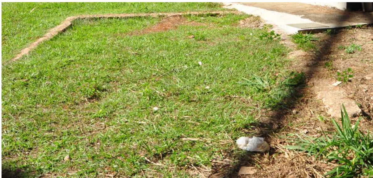
Figura 60: Fundação da Capela no CDTN. Fonte: Acervo da autora, 2025.
