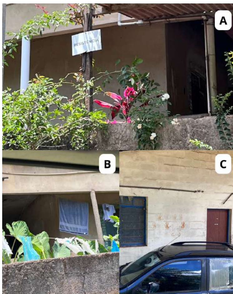
Figura 1. Registros da permanência de moradores no antigo distrito de Bento Rodrigues: A) residência com placa contendo a inscrição “Resistência”; B) indícios de ocupação, como toalha, roupas estendidas e horta em uso; C) veículo estacionado e marcas de mão na parede da garagem, indicando a perplexidade com relação à lama derramada.
