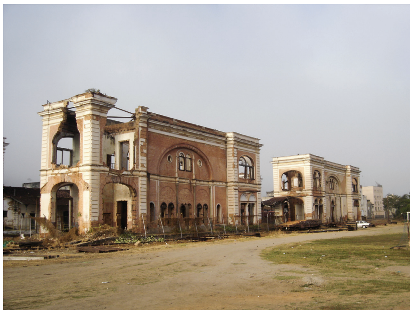
Foto 04: Estação de Porto Novo do Cunha (Além Paraíba – MG)
