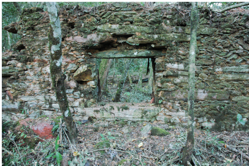
Foto 03: Sítio Arqueológico Capão do Lana: detalhe de parede (vão de janela).
