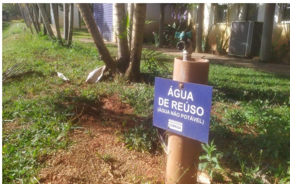
**Figura 20.** Adaptações no sistema de jardinagem da ETE I com água de reúso do efluente tratado
