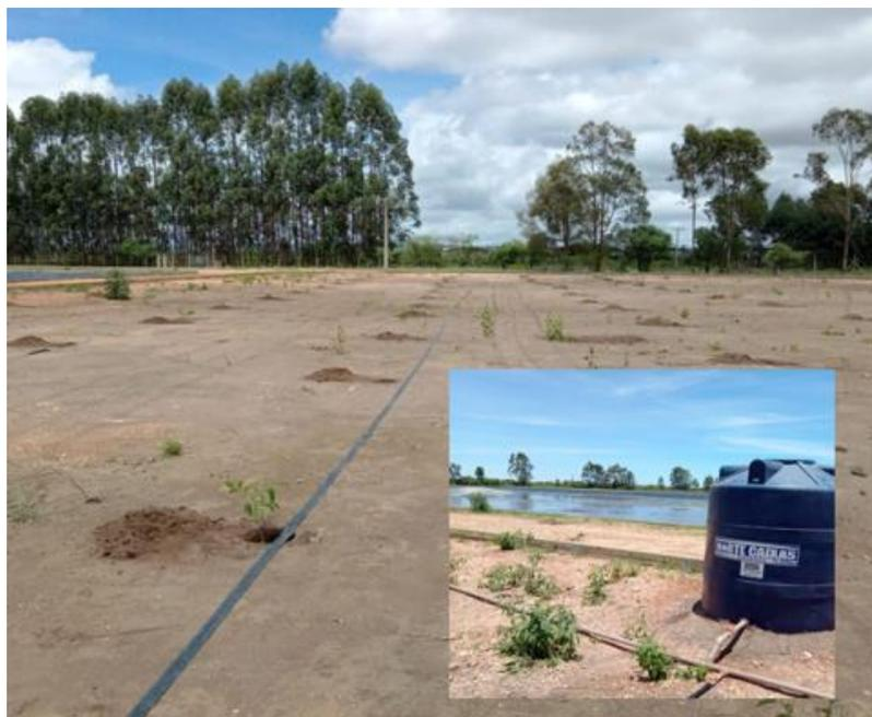
**Figura 21.** Sistema de gotejamento da ETE II para irrigação de mudas nativas com efluente tratado.
