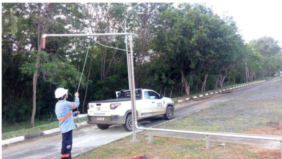
**Figura 16.** Sistema para captação da água de reúso na ETE I.
