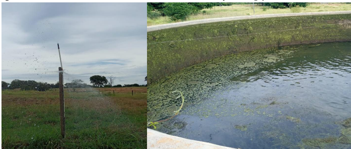
Figura 8. Vazamento nos enrocamentos dos emissores e reservatório para a irrigação.
