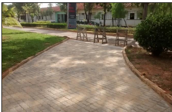
FIGURA 14 - ASSENTAMENTO DE PISO INTERTRAVADO NO ACESSO À CASA DA SAÚDE E NO ESTACIONAMENTO DO CPCA.
