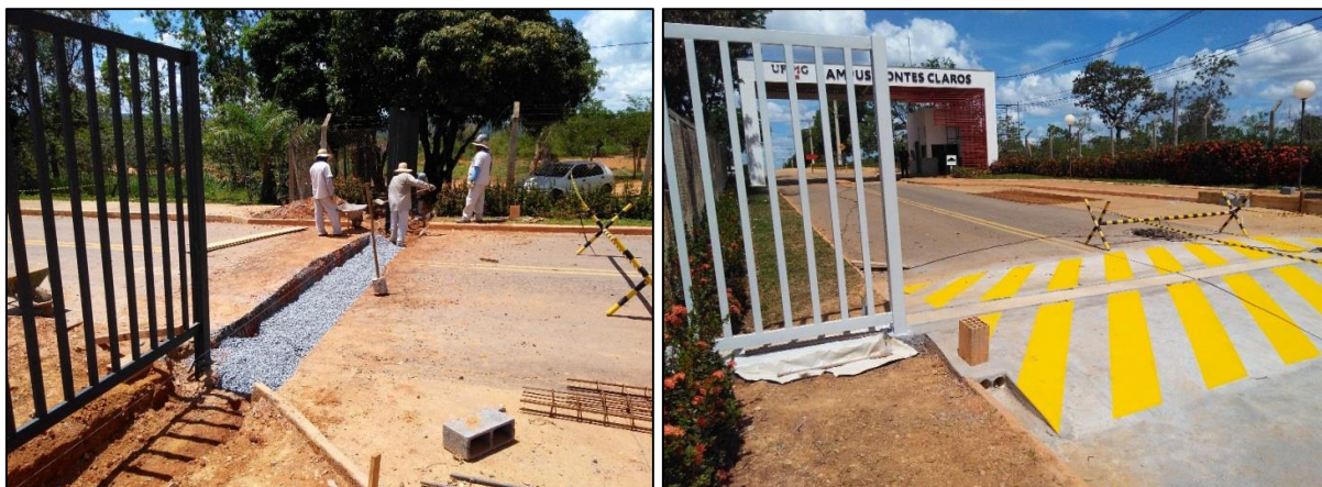
FIGURA 26 - PORTÃO INSTALADO NA GUARITA PRINCIPAL DO CAMPUS DA UFMG EM MONTES CLAROS.
