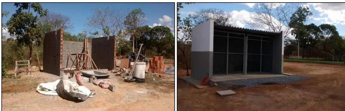
FIGURA 16 - CONSTRUÇÃO DE ABRIGO PARA RESÍDUOS SÓLIDOS.
