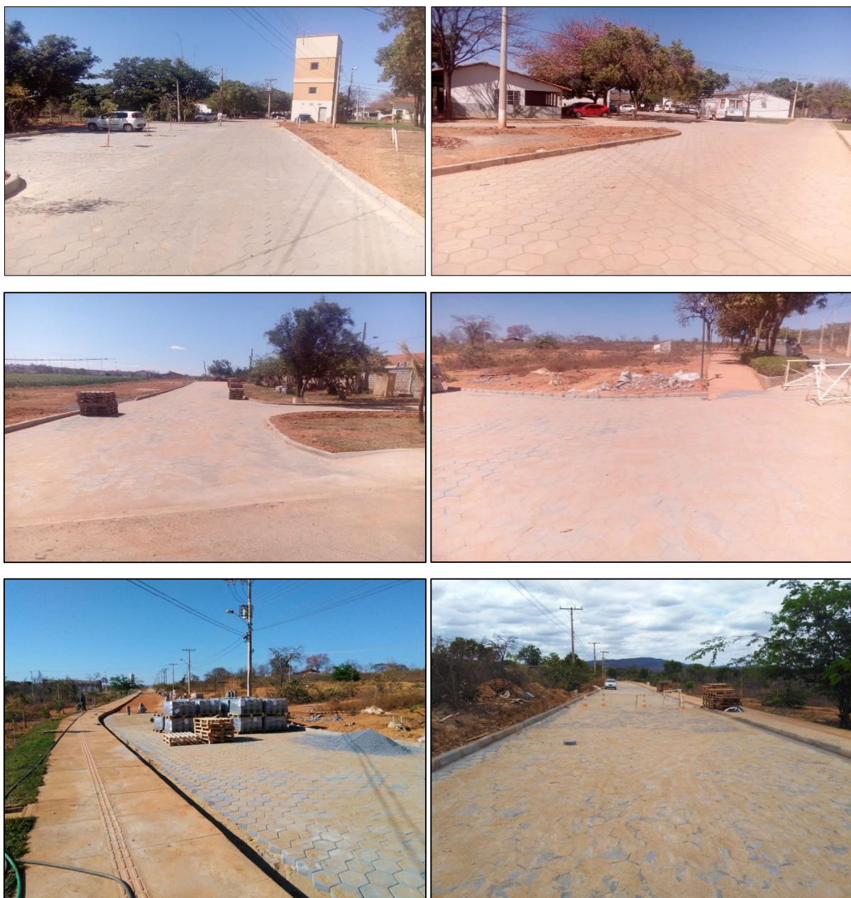
FIGURA 2 - IMAGENS DAS VIAS DE ACESSO SECUNDÁRIO DO CAMPUS DE MONTES CLAROS COM CALÇAMENTO COM BLOCOS SEXTAVADOS.
