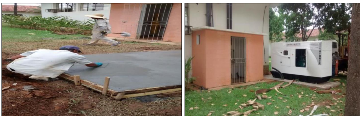
FIGURA 17 - INSTALAÇÃO DE GERADOR DE ENERGIA NO BLOCO A, ADQUIRIDO COM RECURSOS DO FINEP.
