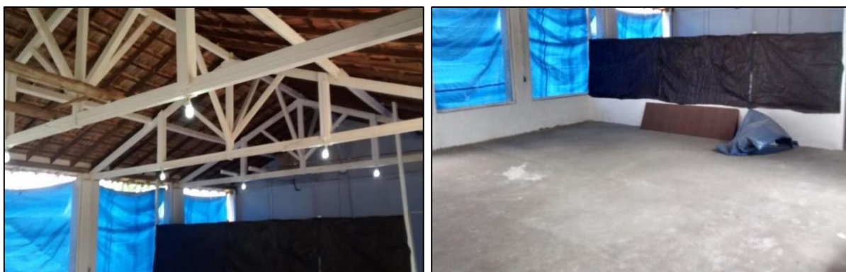
FIGURA 18 - REFORMA DO GALPÃO DE AVES DA FEHAN.
