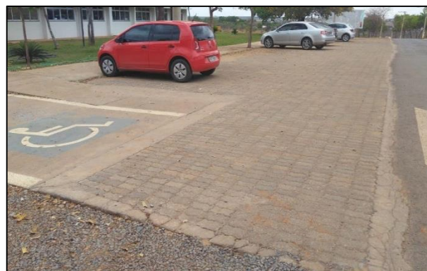
FIGURA 14 - ASSENTAMENTO DE PISO INTERTRAVADO NO ACESSO À CASA DA SAÚDE E NO ESTACIONAMENTO DO CPCA.
