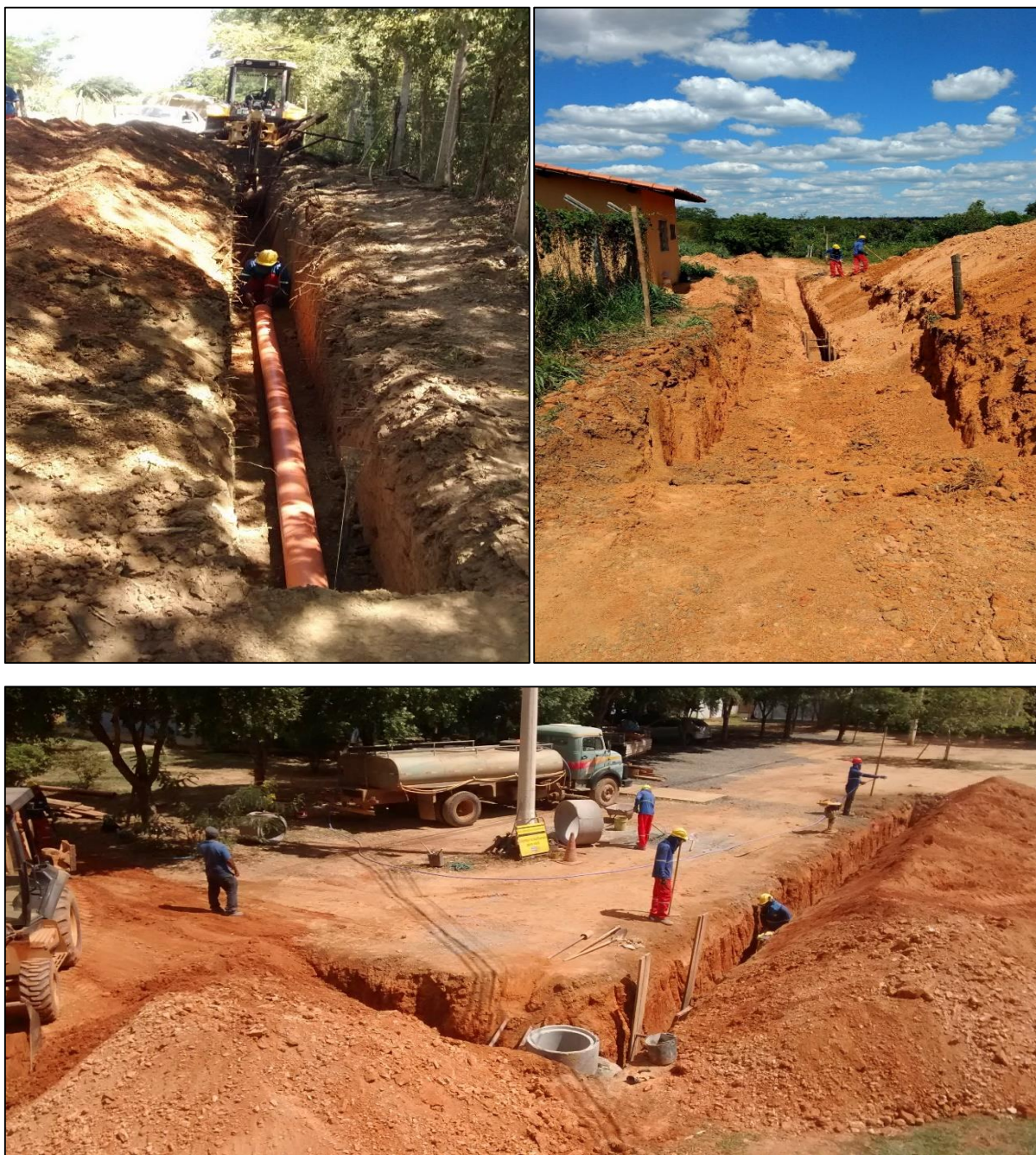
FIGURA 3- INSTALAÇÃO DO NOVO SISTEMA DE ESGOTAMENTO SANITÁRIO PELA COPASA NO CAMPUS DA UFMG EM MONTES CLAROS.
