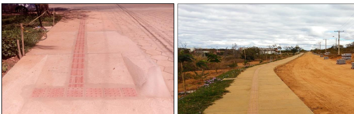
FIGURA 23 - EXPANSÃO DE PASSEIOS PARA ACESSO ÀS EDIFICAÇÕES DO CAMPUS DE MONTES CLAROS .
