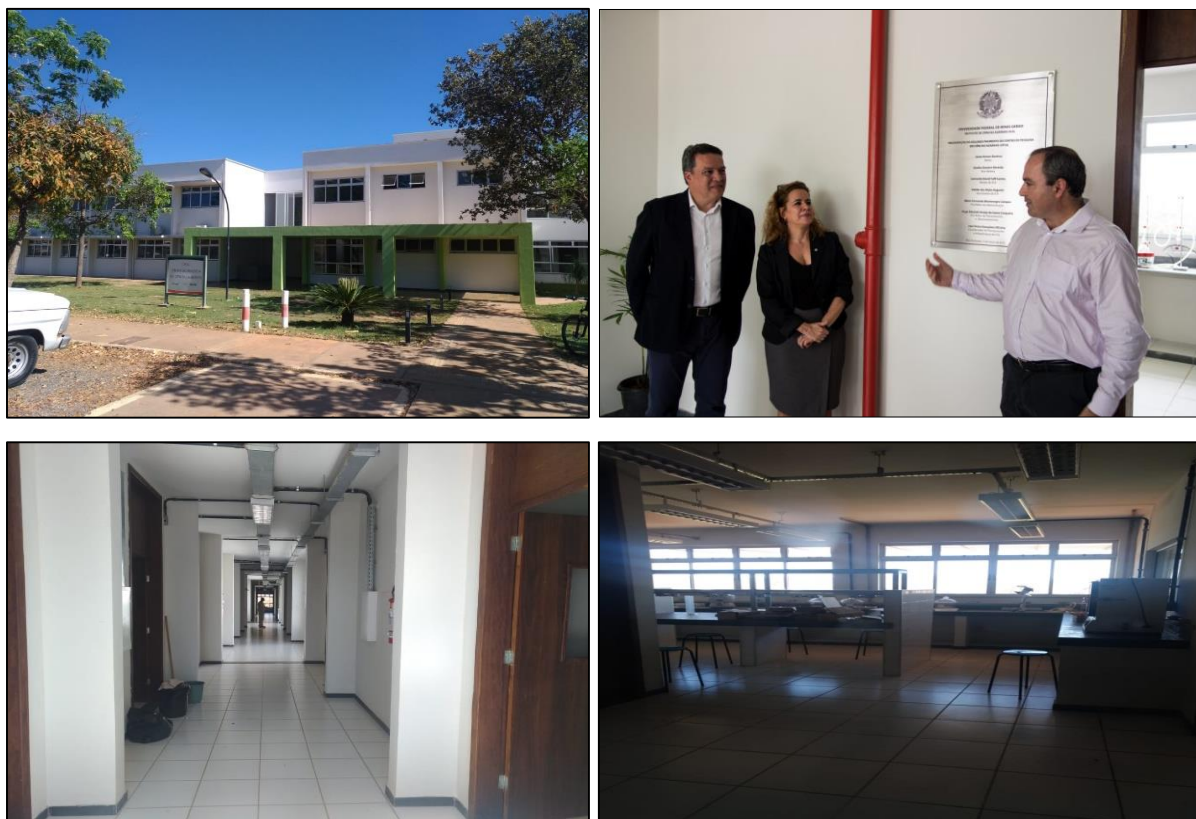
FIGURA 5- IMAGENS DO PRÉDIO DO CPCA CONCLUÍDO COM FACHADA E ÁREAS INTERNAS. FOTO SUPERIOR DIREITA DA INAUGURAÇÃO DO SEGUNDO ANDAR DO PRÉDIO, REALIZADO EM 05 DE MARÇO DE 2018, COM A PRESENÇA DO MAGNÍFICO REITOR PROF. JAIME ARTURO RAMÍREZ E DA VICE-REITORA PROFA. SANDRA GOULARD ALMEIDA.
