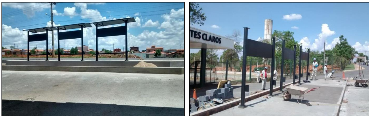
FIGURA 24 - INSTALAÇÃO DE PONTO DE ÔNIBUS EM FRENTE AO PRÉDIO DO CAAD.
