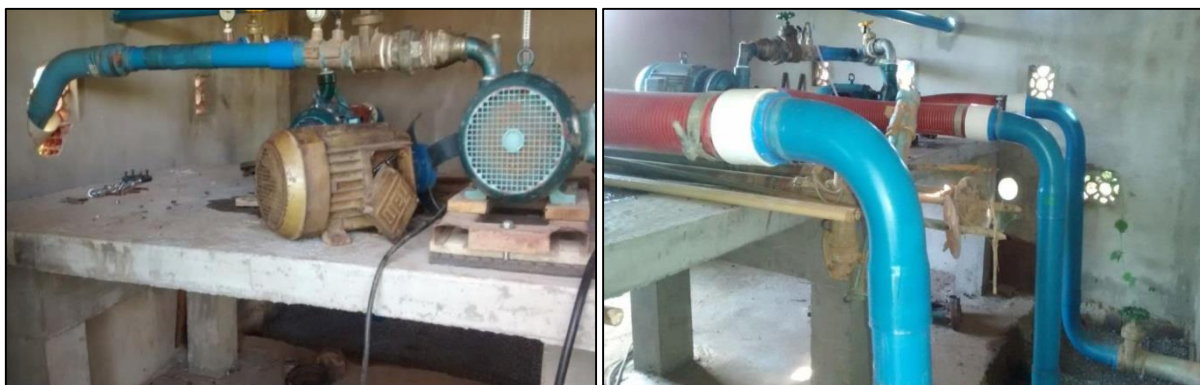
FIGURA 22 - CONSTRUÇÃO DE UMA CASA DE BOMBAS PARA IRRIGAÇÃO NA FEHAN.
