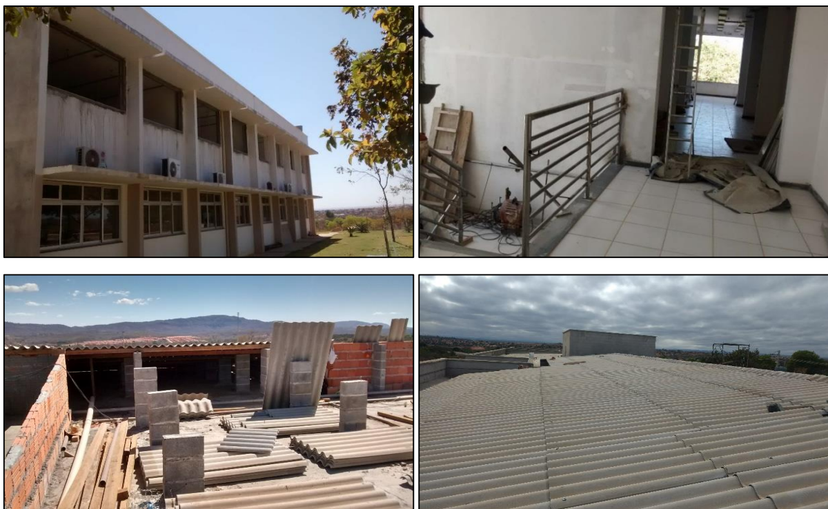
FIGURA 4- IMAGENS DA OBRA DO CPCA COM FACHADA E ÁREAS INTERNAS EM ACABAMENTO E TELHADO EM CONSTRUÇÃO E ACABADO.
