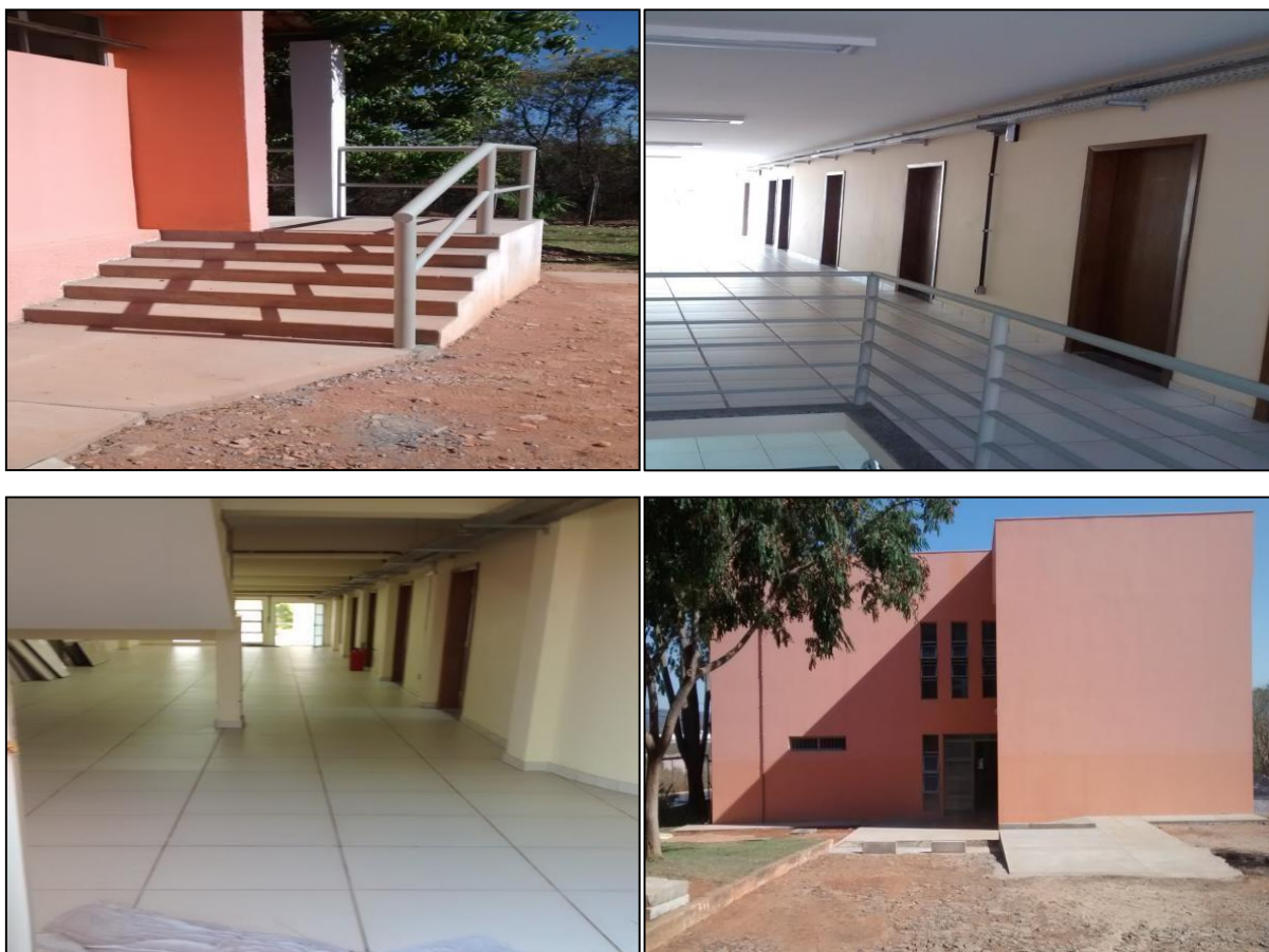
FIGURA 12 - IMAGENS DO ANEXO DO CAAD APÓS AS REFORMAS.
