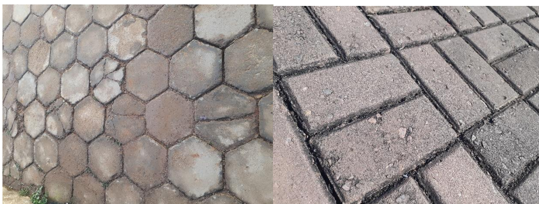
Figura 11: Coleta de dados referente aos pisos feitos de rejeito de Barra Longa
