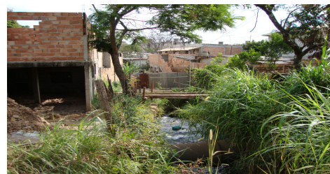
Lotes invadidos e esgoto a céu aberto na equipe 1
