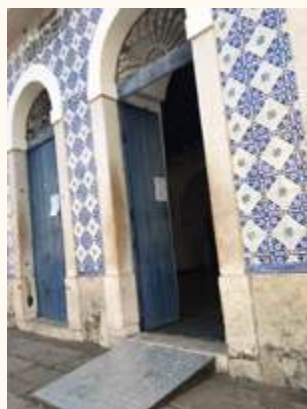
Figura 5 - Rampa de acessibilidade situada na entrada do prédio.
