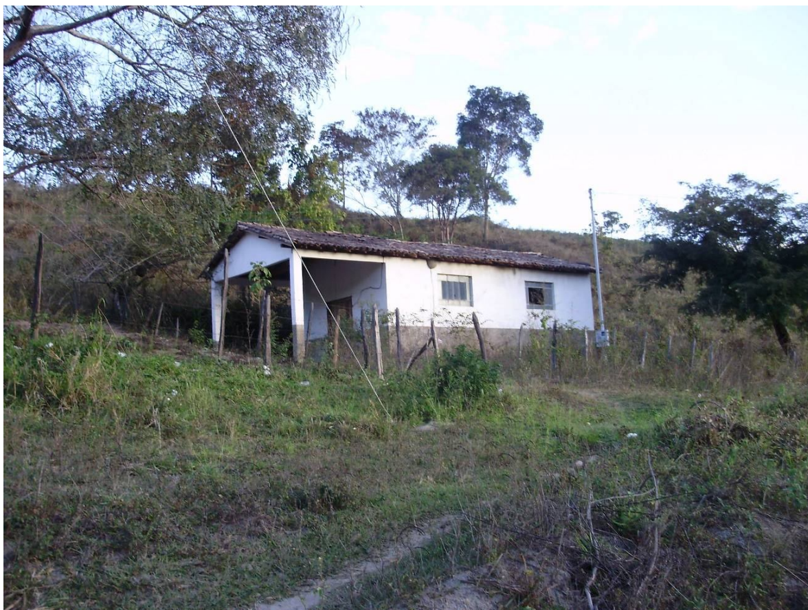
Figura 2: salão da Codevale em Santo Antônio
