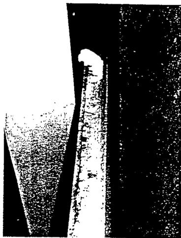
Detalhe da placa de amianto (divisória interna) prensada e parte interior de isopor
