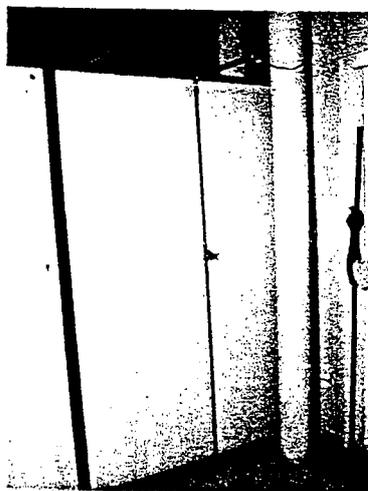
Canalização destinada à instalação de chuveiro de emergência e lava-olhos sem condições de uso
