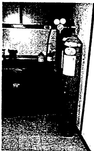
Cilindros de gases armazenados em local inadequado, sem correntes de proteção, sujeitos a queda.
