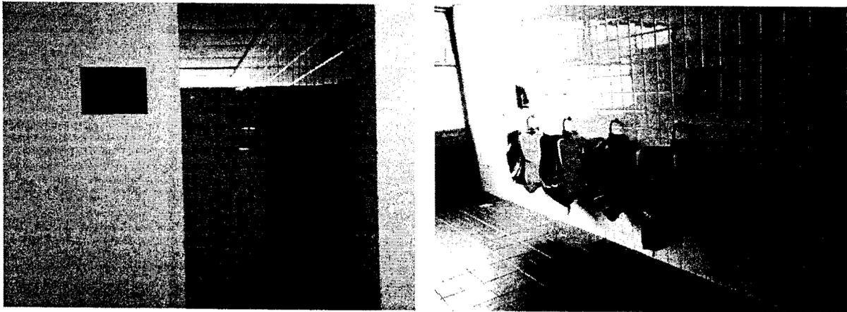
Fotos 027 e 028: Banheiro masculino no 1º andar com mictórios inutilizadas por impossibilidade de reparo na rede hidro-sanitária.
