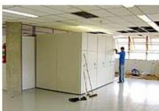
Montagem da estrutura concluída
