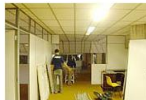
Instalação de porta dupla
