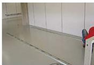
Instalação dos trilhos
