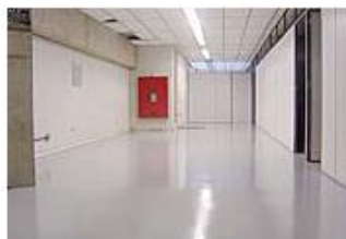
Piso seco após 72 horas (corredor)
