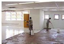
Pintura da sala
