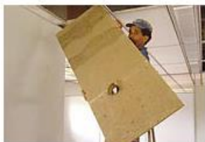
Retirada das placas do forro
