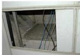
Detalhe do forro da sala provisória
