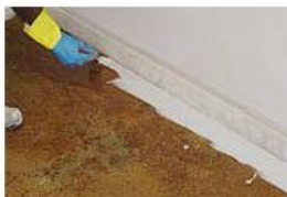
Início da pintura da sala (recortes)
