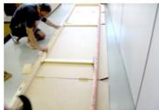
Início da montagem
