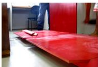
Fixação do painel vertical
