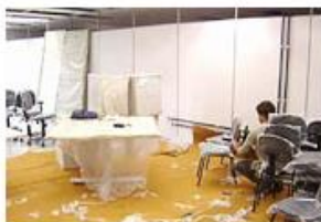
Montagem das cadeiras fixas
