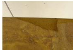
Remoção do carpete (sala, detalhe)
