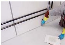
Acabamento dos rodapés
