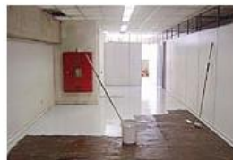
Pintura do Corredor
