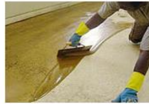
Aplicação de Resina (Primer Epoxi)
