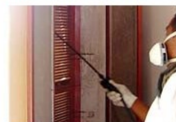
Dedetização das saídas de ventilação
