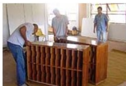
Remoção dos armários
