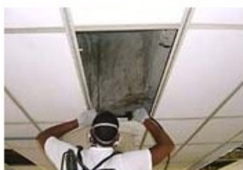
Dedetização das placas do forro
