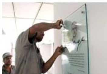
Fixação da placa
