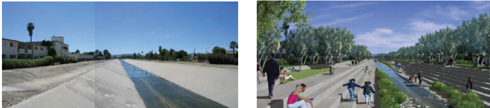
FIGURA 10 - Um dos trechos do Rio Los Angeles antes (esquerda) e depois (direita) da intervenção Fonte: LOS ANGELES, 2007.
